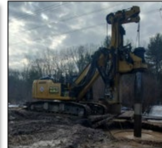
Plataforma de perfuração
